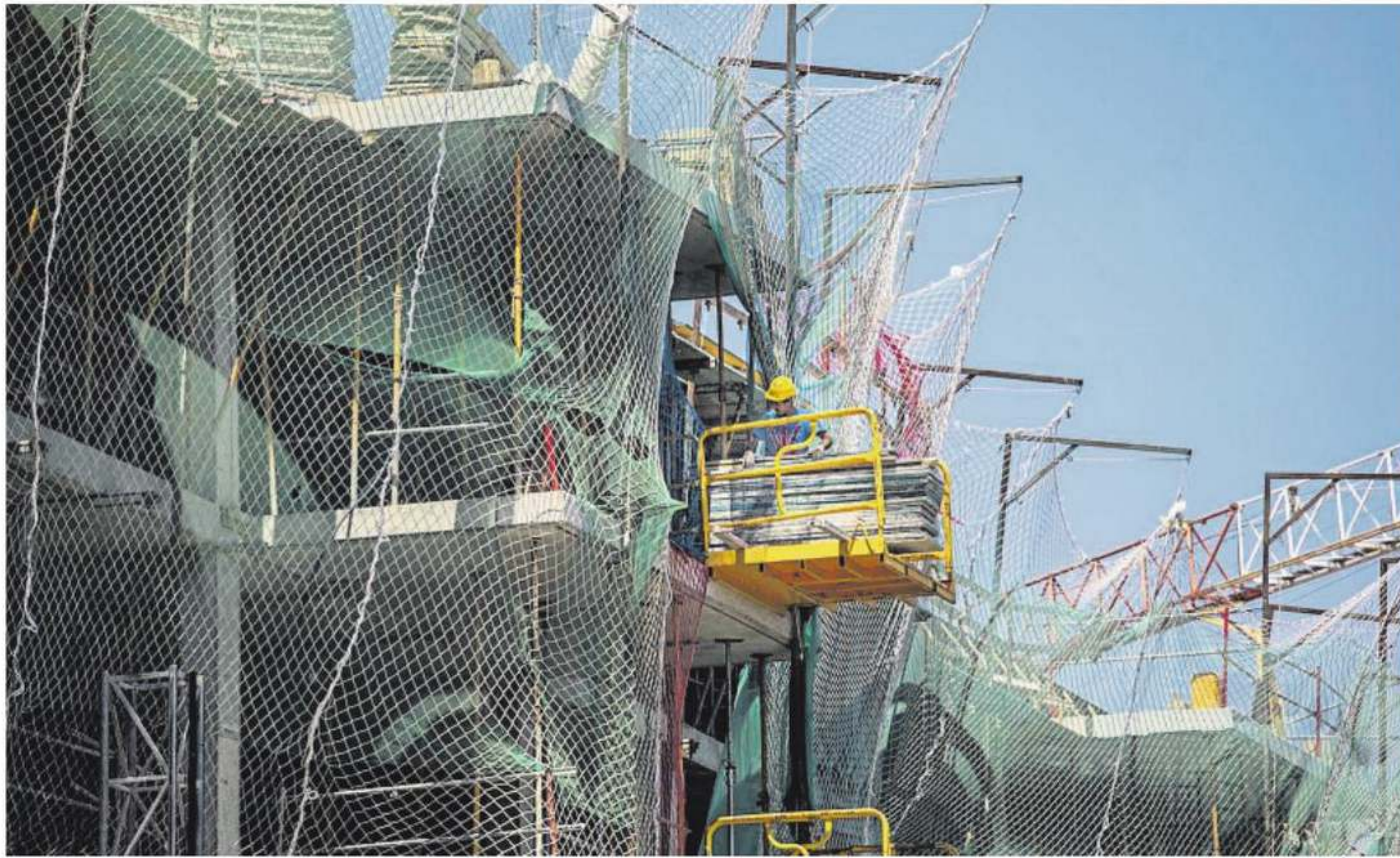
Un edificio en construcción en Sant Cugat del Vallès
