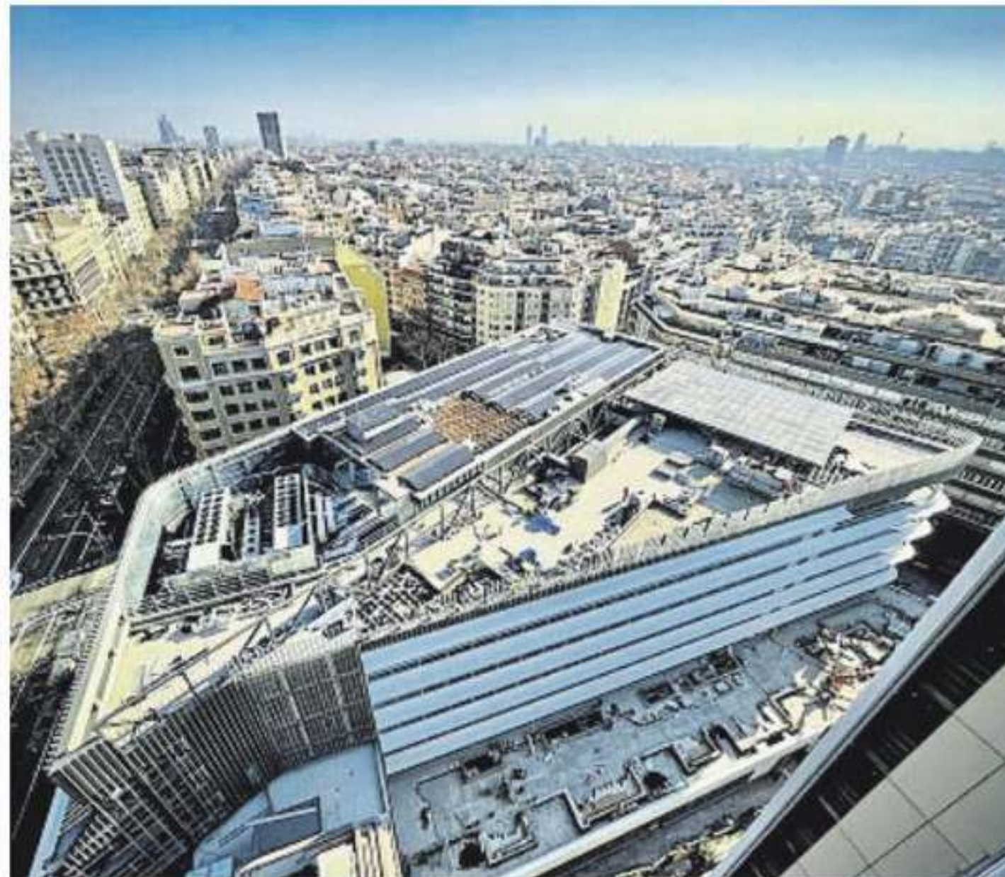
Obras en la cubierta del edificio situado en Diagonal 471
